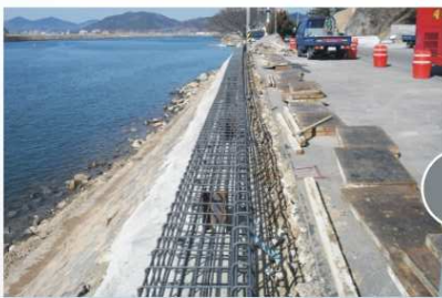
토공 및 철근 설치
