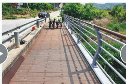
바닥판 및 난간 설치
