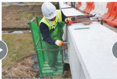
케미컬 앵커 설치
