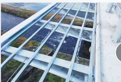
장선 및 보강설비 설치
