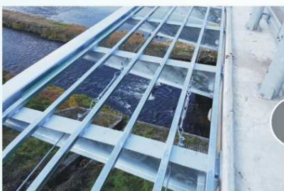
장선 및 보강설비 설치
