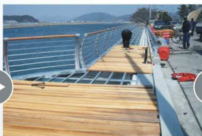
바닥판 및 난간 설치
